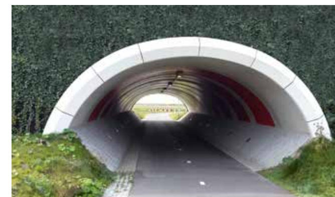
Met een boogconstructie wordt optimaal gebruik gemaakt van de materiaaleigenschappen en de krachtverdeling van het beton.
