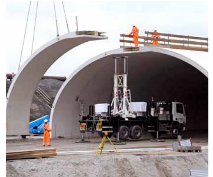
De prefab boogconstructies zijn uitermate geschikt voor een eenvoudige en snelle installatie die wegafsluitingen en wegomleggingen aanzienlijk verkort.
